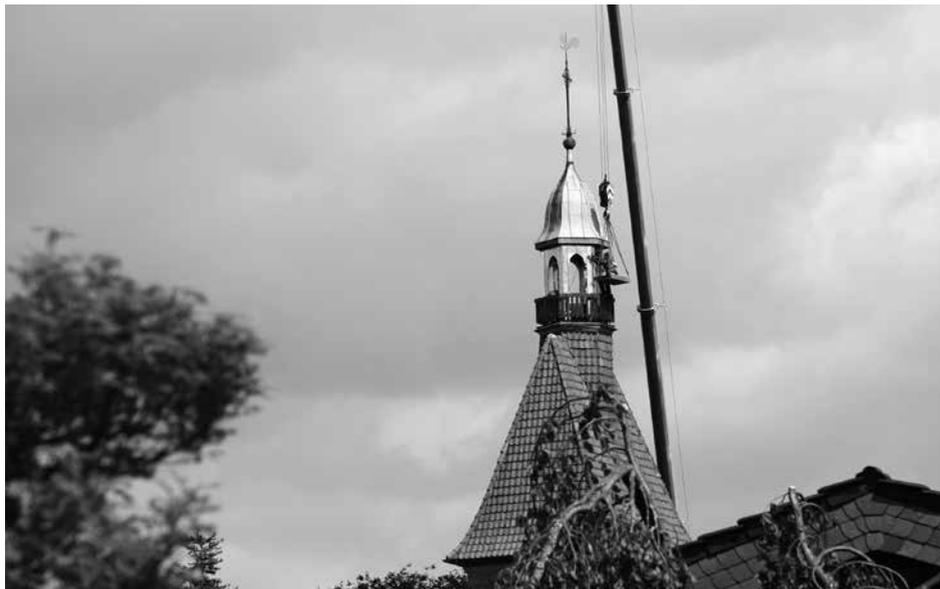
Im Frühjahr 2020 wurden die äußeren Hölzer der Turmspitze vollständig mit Kupferblech verkleidet. Dies war notwendig geworden, da die Witterung die Holzbalken anzugreifen drohte.
